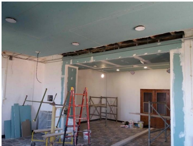
Renovación del techo del comedor
