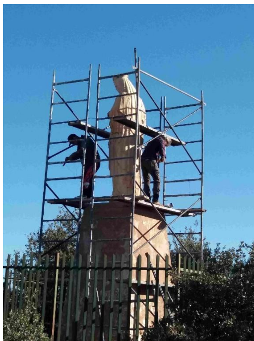
Colocación del andamio
